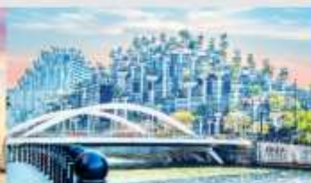
อาคารฟันทันไม้
