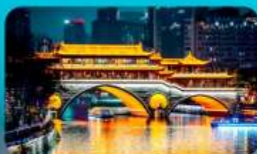
สะพานอันชุน
